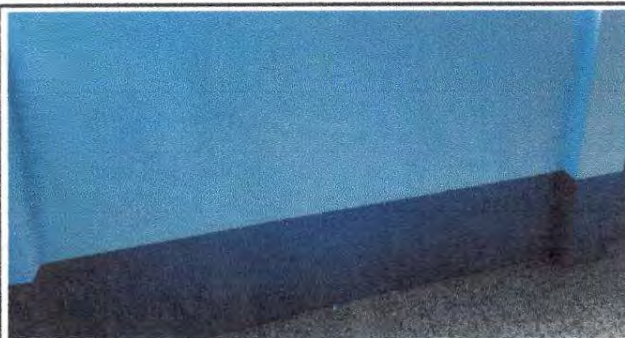
Foto 15: Pintura en muros interiores del modulo 2
