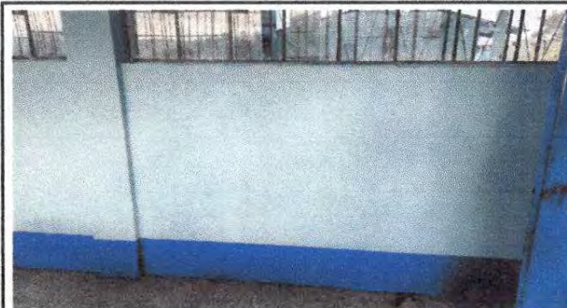
Foto 16: Pintura en muros interiores del modulo 1
