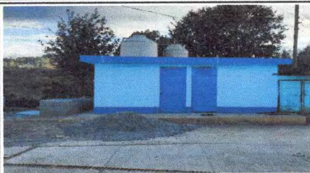
Foto13: Pintura en muros exteriores
