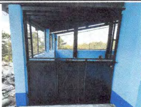
Foto 1: Mantenimiento de estructura: lijado y aplicación de pintura en puerta de metal del módulo 2 cocina
