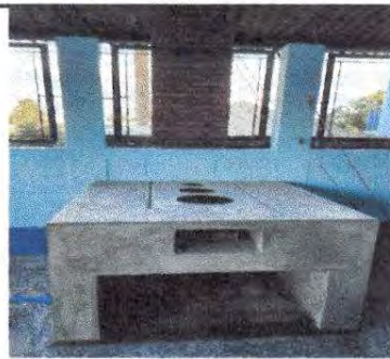
Foto 6: Sustitución de estufa rural incluye chimenea de ladrillo y plancha de metal en módulo 2 cocina
